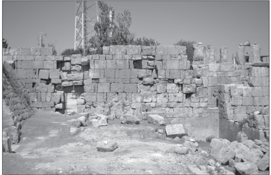
١٠. الجدار الغربي من الداخل قبل الترميم.
