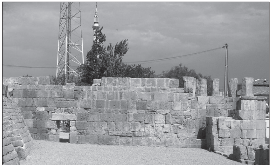
١١. الجدار الغربي من الداخل بعد الترميم.
