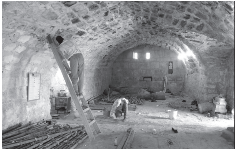
١٧. المسجد من الداخل قبل الترميم.
