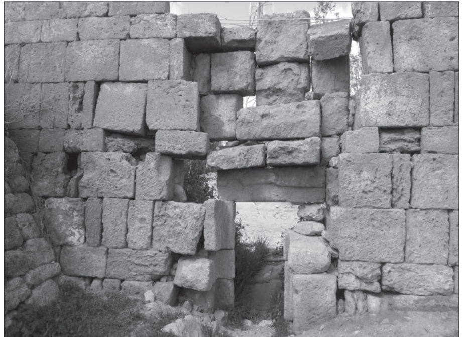
١. مدخل الجدار الغربي من الداخل قبل الترميم.
